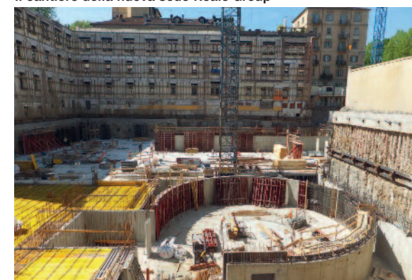
Il cantiere della nuova sede Reale Group
