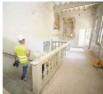
Uno dei tecnici al lavoro per il restauro dell'edificio
